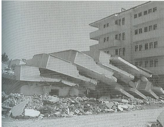
Fig. 2.26. Prăbușirea unei clădiri în timpul cutremurului din Izmit, Turcia, August 17, 1999
