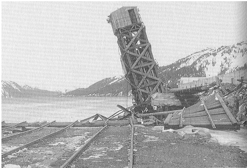
Fig. 2.23. Degradare cauzata de tsunami în timpul cutremurului din Alaska, Martie 27, 1964
