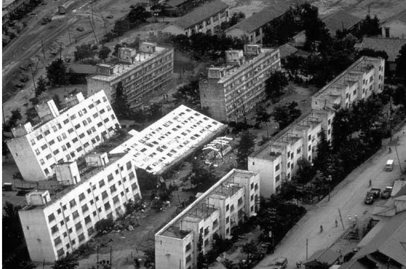
Fig. 2.28. Răsturnarea unui ansamblu de blocuri la Kawagishi – Cho, Niigata, ca urmare a lichefierii terenului de fundare în timpul cutremurului din 1964
