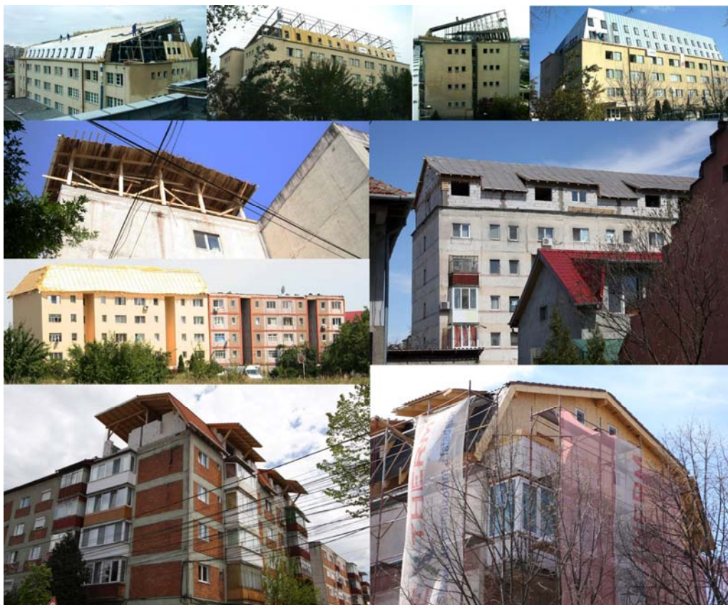
Fig.6.1. Mansarde existente pe structuri variate
