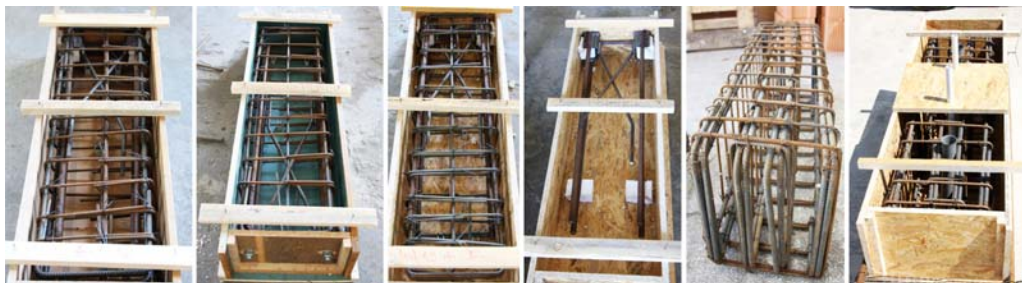
Fig. 7.4. Elemente înainte de turnare
