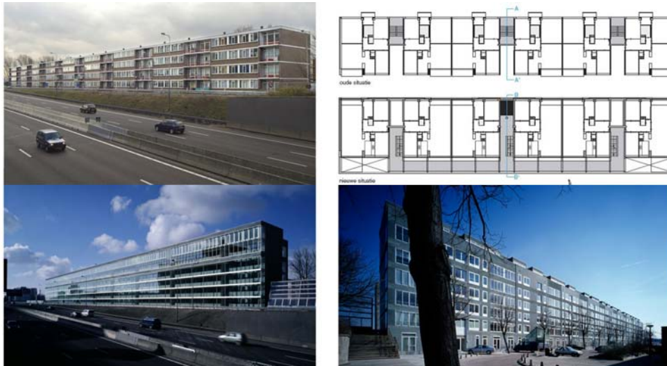
Fig.4.7. SuRE-FIT, exemplu Amsterdam, Leeuw van Vlaanderen [ http://www.nationalerenovatieprijis.nl/archief/nrp2007/Inzendingen/Woningbouw_Renovatie/De_Leeuw_van_Vlaanderen_Amsterdam.html ]
