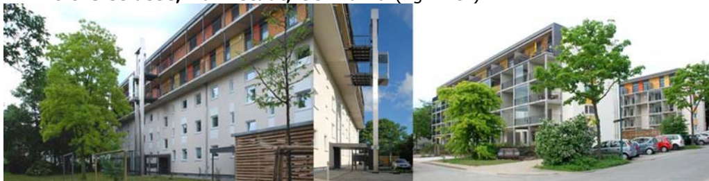
Fig.4.19. SuRE-FIT, exemplu Darmstadt, Moltkerstrasse [http://www.detail360.de/projekt/modernisierung-und-aufstockung-von-2-mehrfamilienhaeusern-moltkestrasse-27-37-darmstadt-pjid_3371.htm?fotoid=3]
