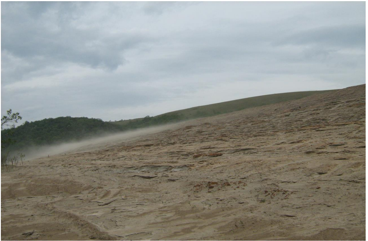
Fig.54 Iaz de decantare Sasca Montana - 2007
