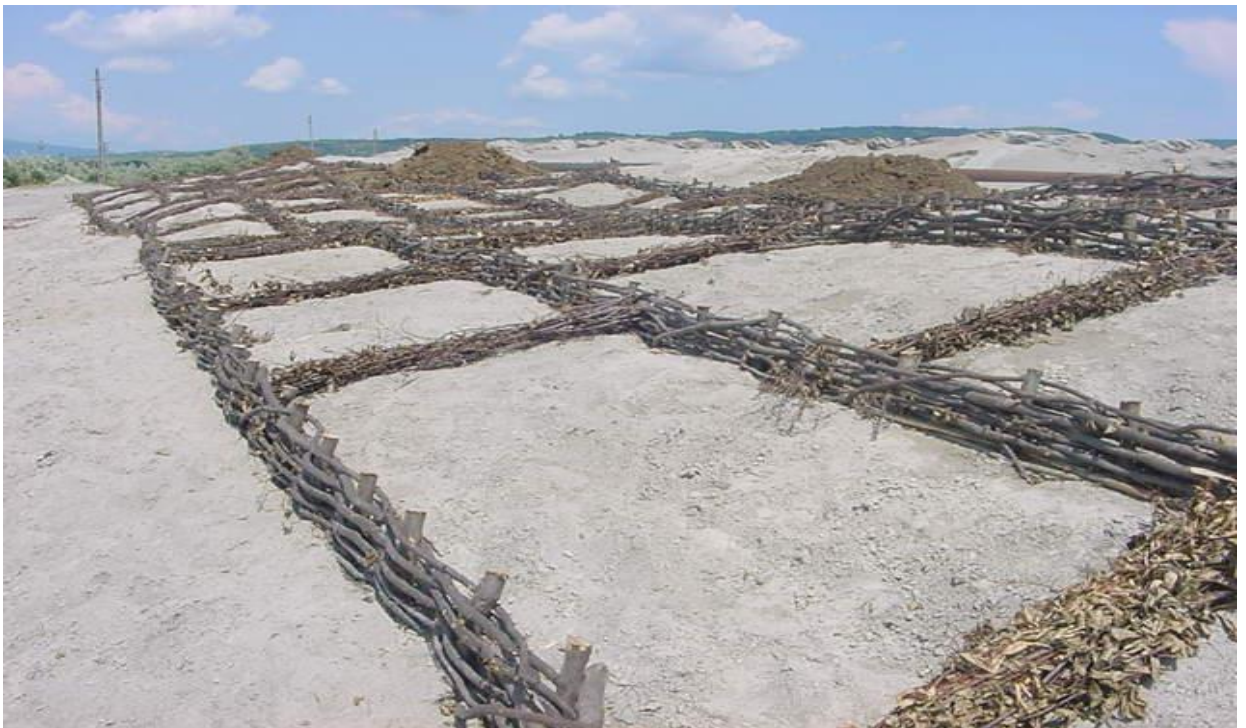
Fig. 55 Reconstrucție ecologică prin împădurire – Amenajare teren- Steril iaz Moldova Nouă - 2003
