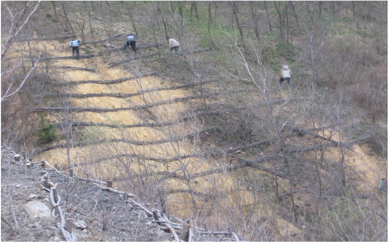
Fig. 62 Execuție terase sprijinite pe gărdulețe- Perimetrul Sichevița
