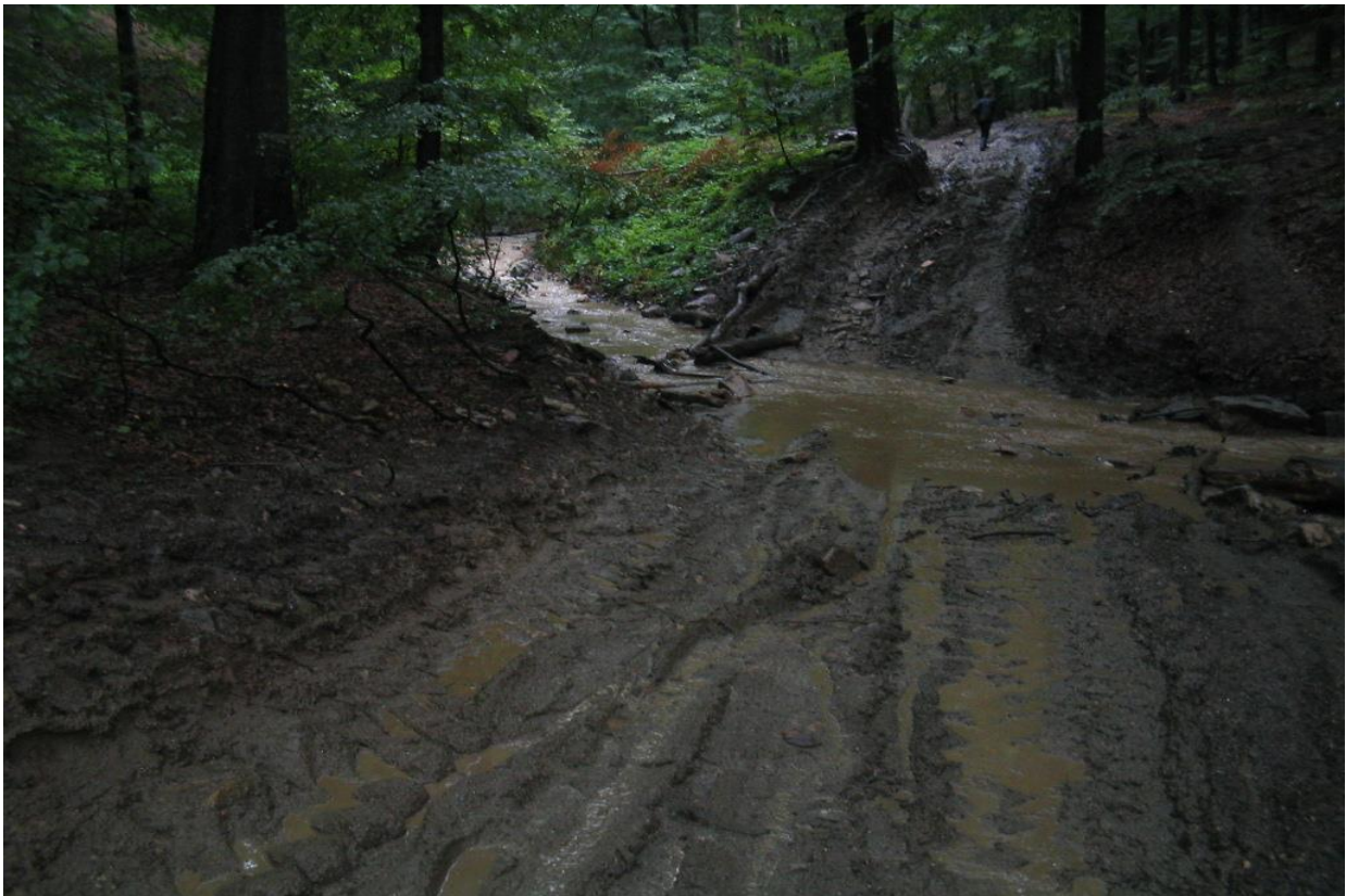
Fig. 23 Drum neamenajat, degradare sol, poluare ape de suprafață zona Prigor
