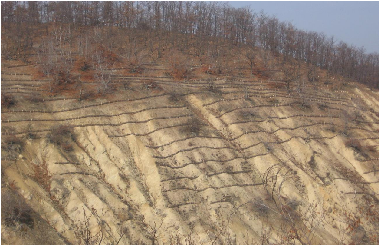
Fig.64 Amenajare terenuri forestiere degradate de eroziune în suprafață excesivă și eroziune de adâncime - Perimetru SICHEVIȚA
