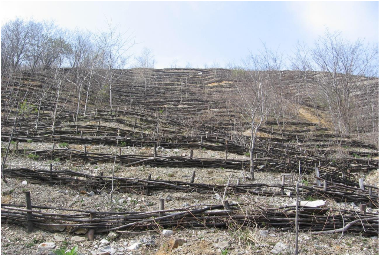
Fig.46 Perimetrul de ameliorare Valea Mare Moldova Nouă - teren amenajat prin terase sprijinite cu gărdulețe
