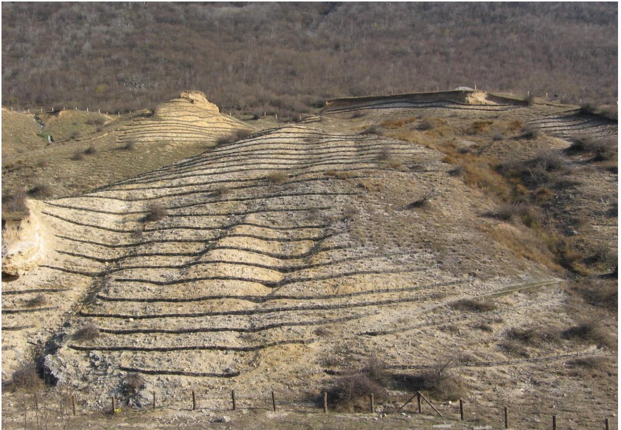
Fig.42 Perimetrul de ameliorare Pecsari – teren degradat de eroziune și alunecări ( Coronini ) anul 2006
