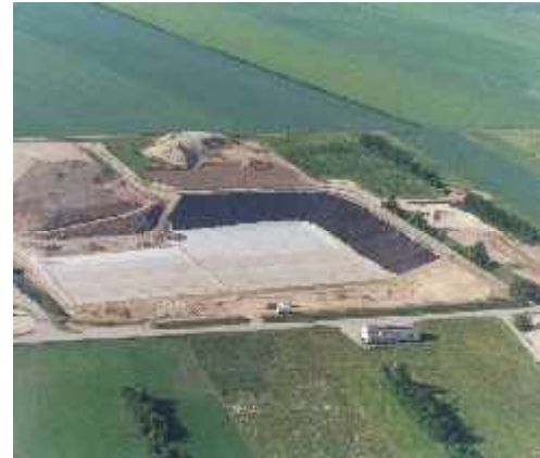
Figura 5.2: Depozit pentru soluri tratate
