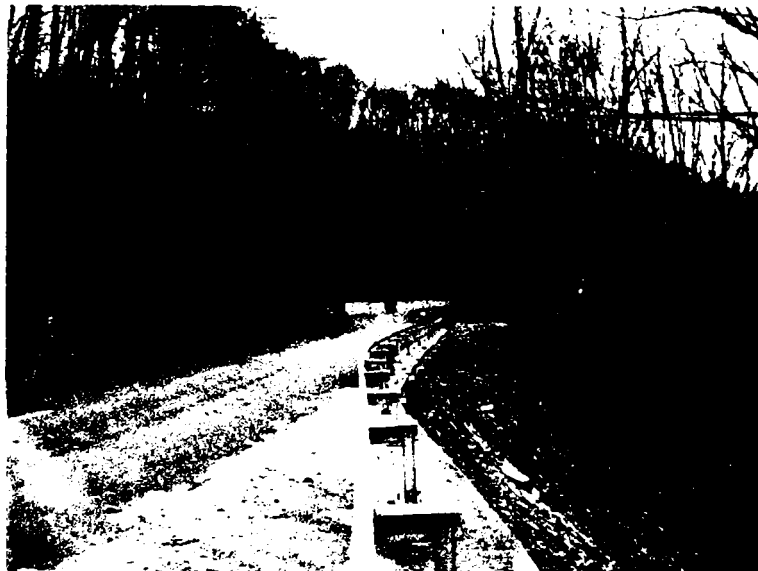
Figura 5.55. Capetele protejate ale ancorelor după operațiunea de pretensionare.
