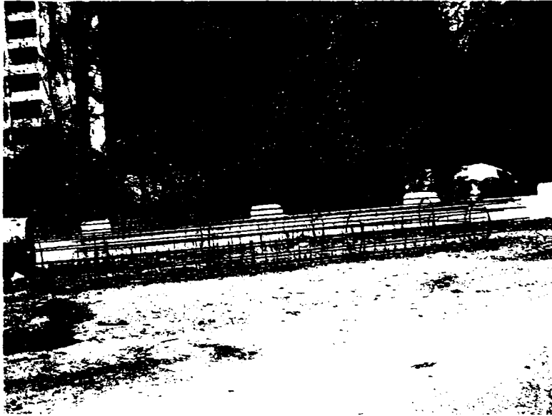
Figura 5.48. Carcasă pentru armarea coloanelor.
