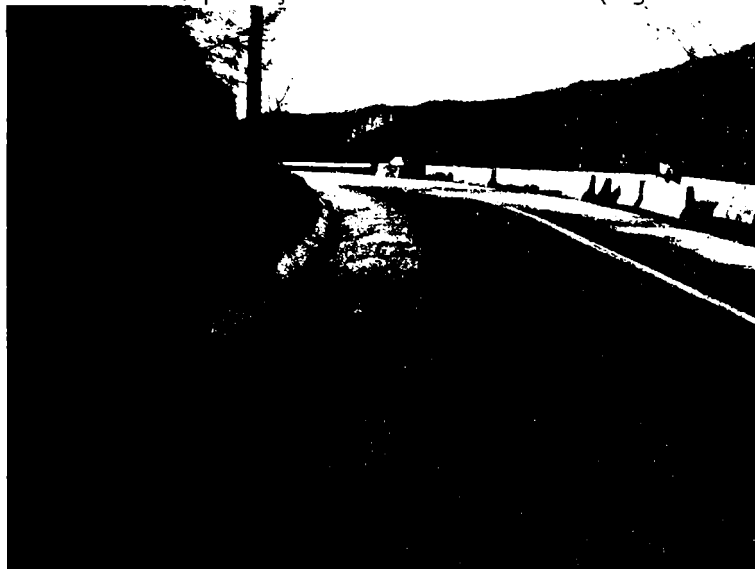
Figura 5.27. Rigolă de colectare și dirijare a apelor din precipitații.
